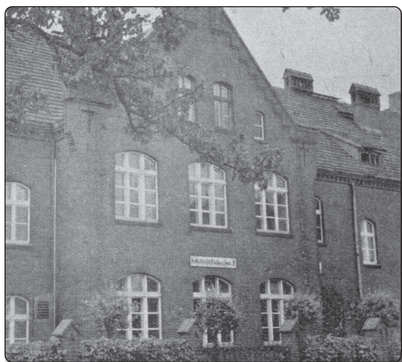
Budynek szkoły katolickiej w Groszowicach.
